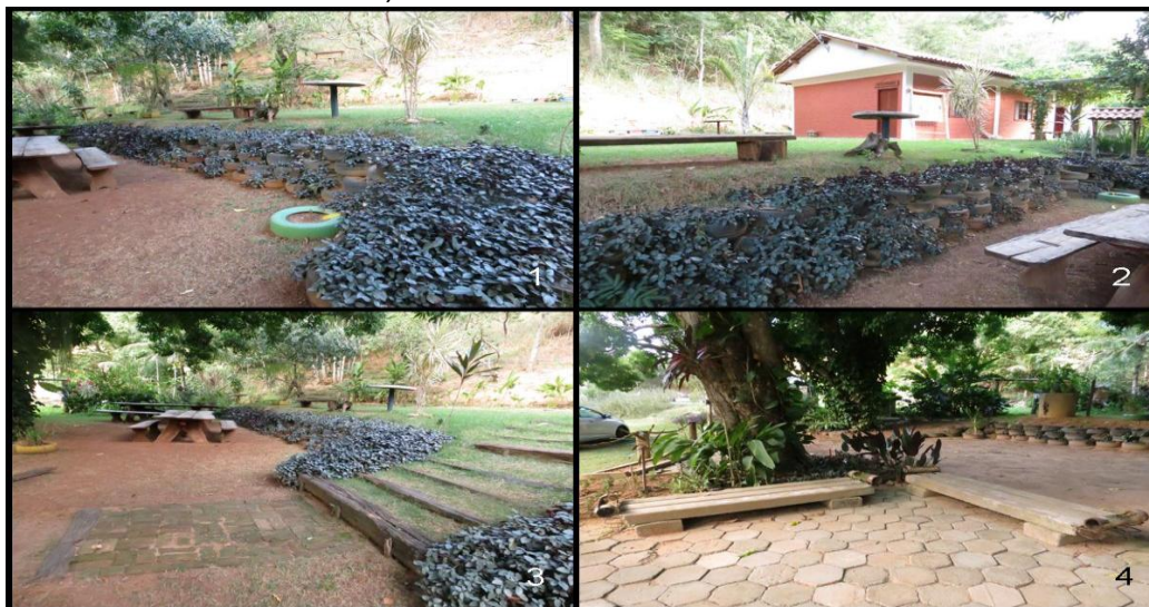
Figura 2. 1 e 2 reaproveitamento de pneus na jardinagem e contenção de pequenas encostas; 2 – uso de estacas e tijolos de demolição para a construção de escadas; 3- hastes de concreto descartadas para a confecção de bancos de jardins. Fonte: Pesquisa.
